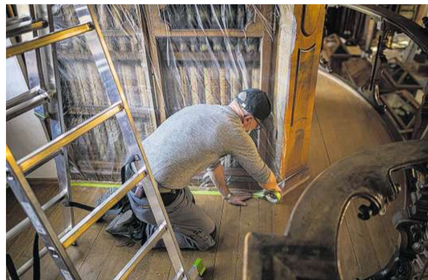
Bevor sie ans Werk gehen, decken die Fensterbauer die wertvollen Bücher mit einer dünnen Folie ab und bauen dann eine luftdichte Unterdruckkabine auf.
