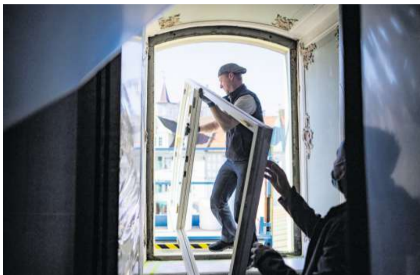
Der Einbau der neuen Hightech-Fenster erfordert von den Fensterbauern höchste Konzentration und Vorsicht.
