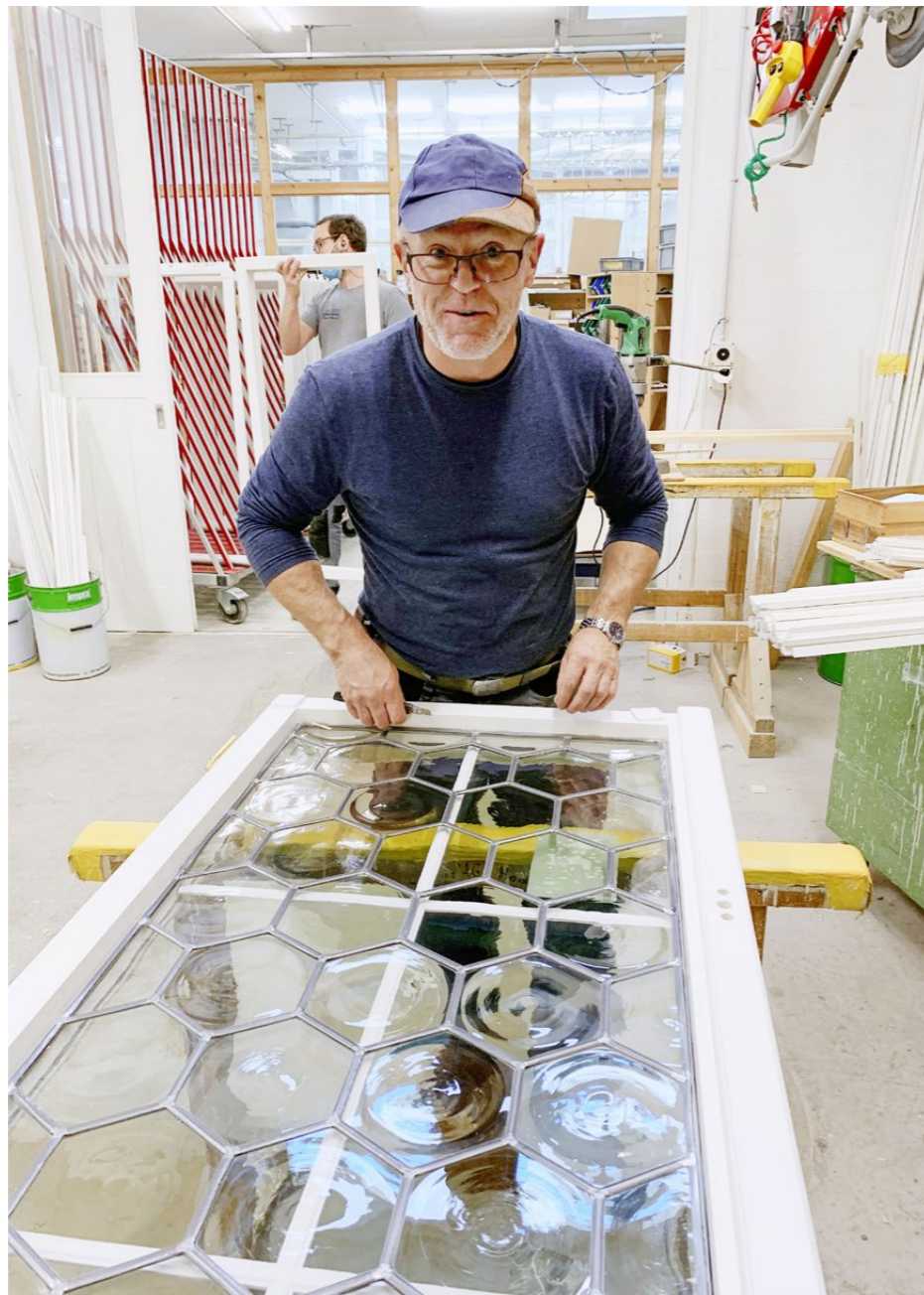
Die bleiverglasten Wabenscheiben aus mundgeblasenem Glas wurden ausgebaut, restauriert und im neuen Fenster raumseitig wieder verwendet.
