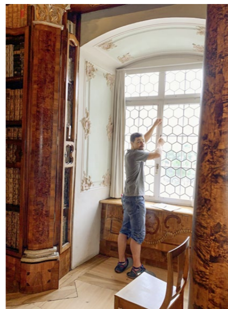
Vor dem Ausbau wurden die alten Fenster millimetergenau vermessen.
