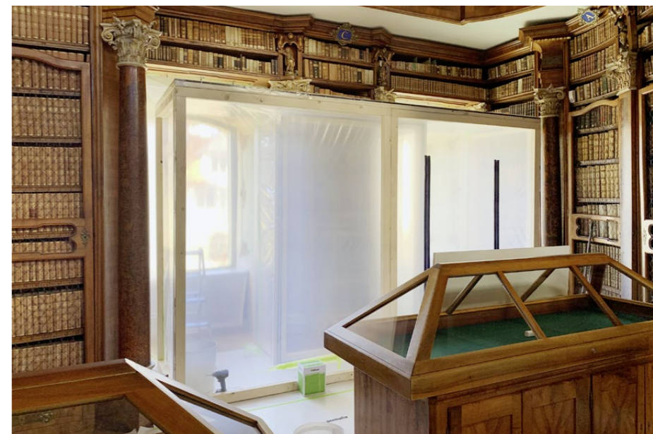
Im Bereich der Ein- und Ausbaurbeiten stellten die Handwerker eine Kabine aus Folie auf, aus der mit einer Filteranlage kontinuierlich die verschmutzte Luft abgesaugt wurde.
