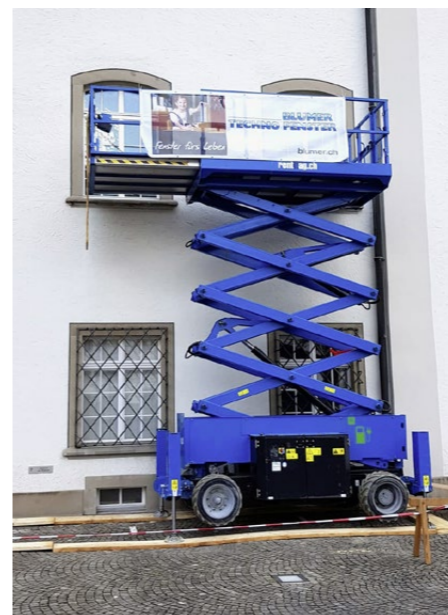
Über eine Hebebühne wurden die Fenster in die Obergeschosse gehoben und dort angepasst.
