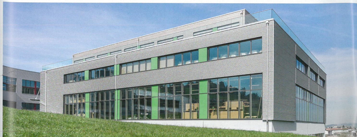
■ Blumer Techno Fenster AG hat beim Neubau bereits mit der neuen CNC-gesteuerten Anlage gefertigte Fenster eingesetzt – sie sind bestes Anschauungsbeispiel.
